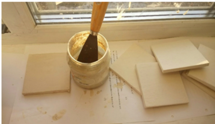
Рисунок 4 - Грунтование шпателем
