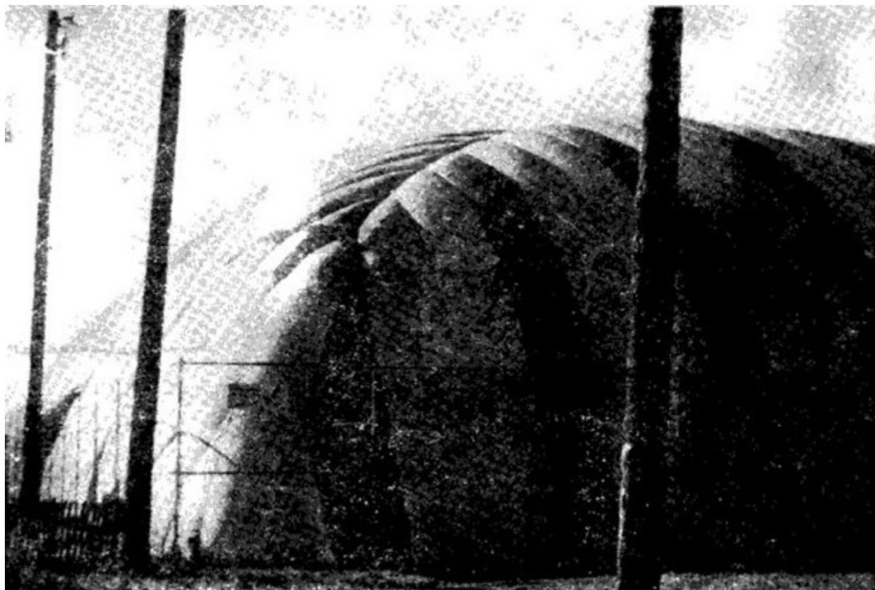
**Рис.8. Воздухоопорное сооружение усиленное канатами. Фирма «Ирвинг»**
