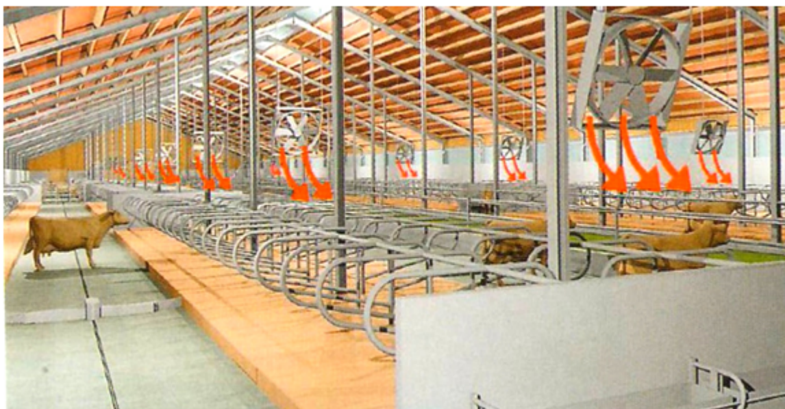
Рис. 2. Принцип организации движения воздуха посредством осевой вентиляции
